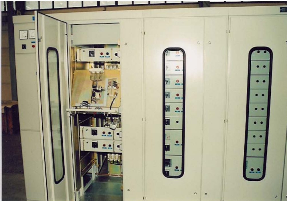
ÜST ÇEKMECELER TAMİR KOLAYLIĞI İÇİN YATIK VAZİYETTE DURABİLMEKTEDİR
